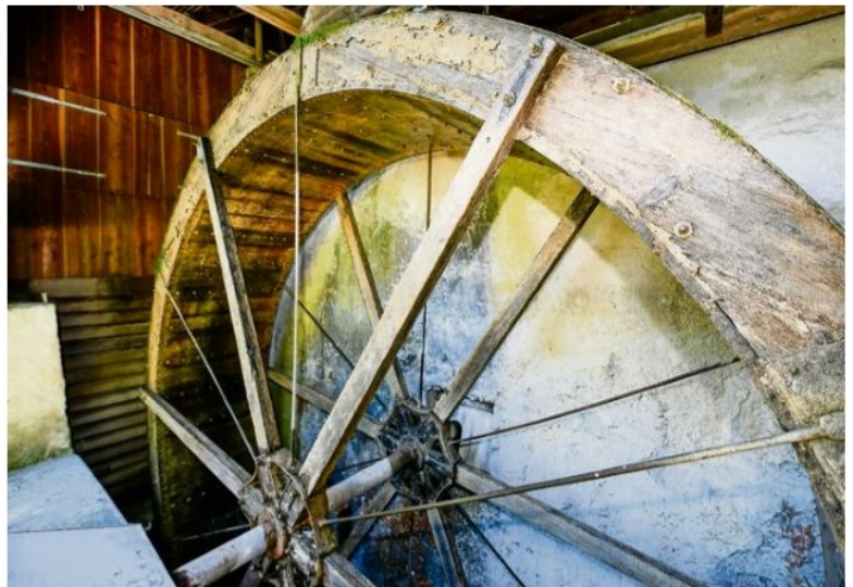
Das grosse Wasserrad der Sagi misst stolze 5 Meter und 40 Zentimeter im Durchmesser. Nach 38 Jahren in Betrieb muss es nun allerdings bald ersetzt werden, doch der Sagi-Genossenschaft fehlen einige Tausend Franken hierfür.
